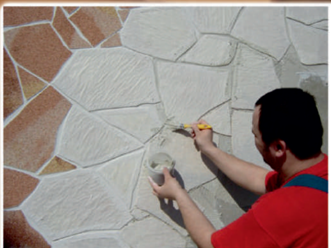
5. Verfugen der Fugen, der Fliesenkleber selbst ist das Verfugungsmaterial.
